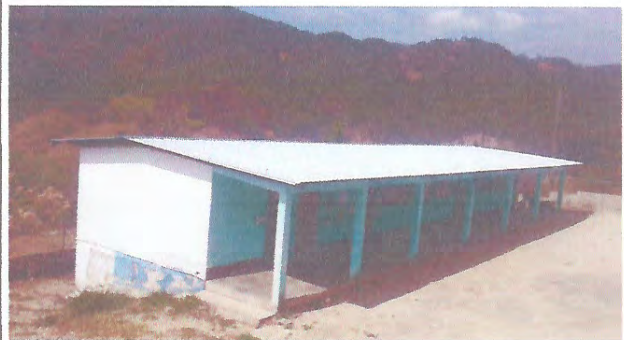
Foto 4: Mejoramiento de repello y cernido de paredes
